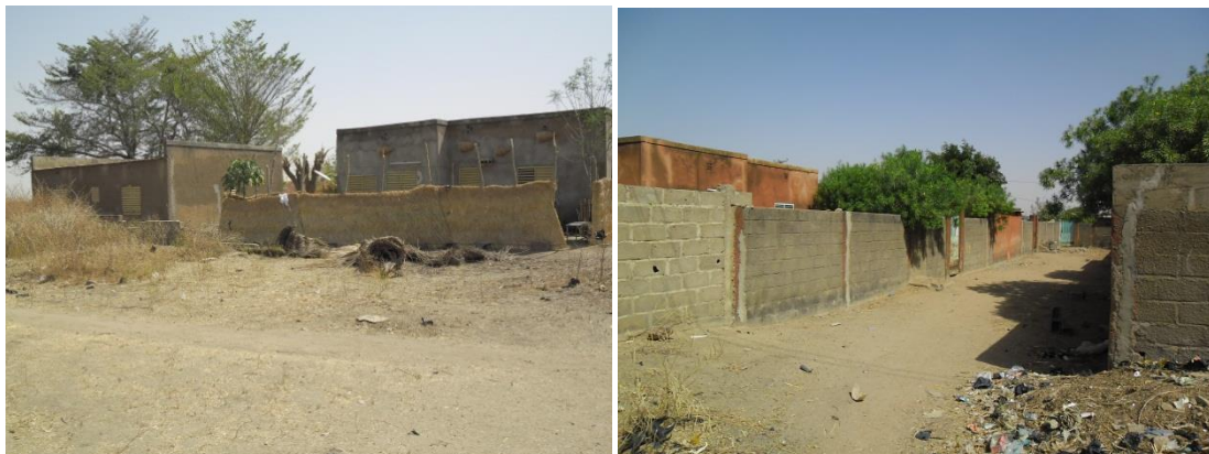
Vue sur un logement de type mixte banco enduit en ciment
