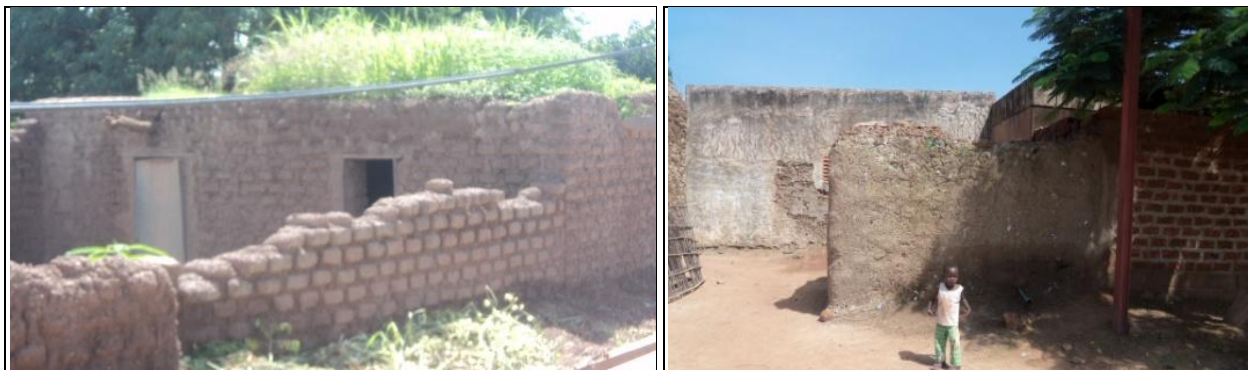
Photo n°02 : Habitat traditionnel en banco avec toiture terrasse en banco
