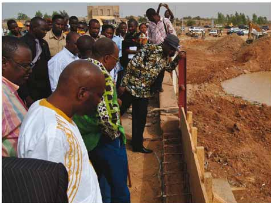
Le Premier Ministre sur le Chantier de réalisation du Canal Bangr-Wéogo
